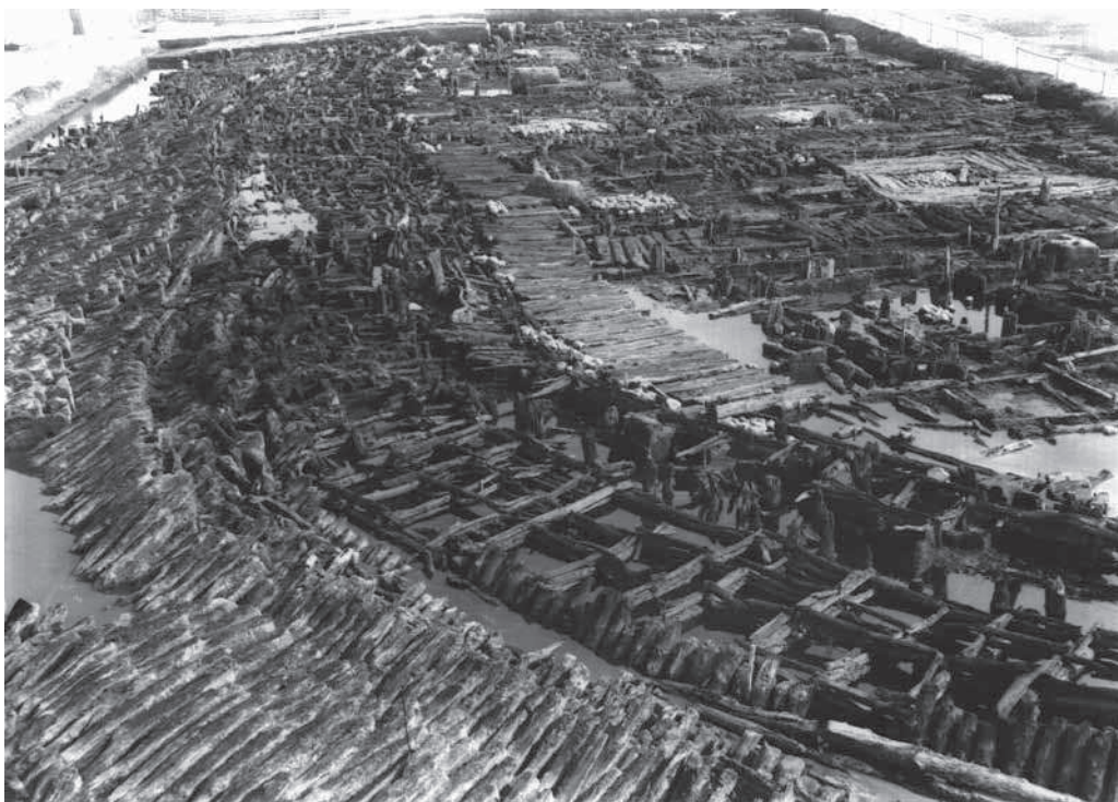
Ryc. 1. Biskupin 1939 r. Drewniane konstrukcje osiedla obronnego kultury łużyckiej na półwyspie Jeziora Biskupińskiego. Na pierwszym planie falochron i skrzyniowy wał obronny, dalej ulica okrężna i rzędy domów między ulicami poprzecznymi. Fot. Archiwum Muzeum Archeologicznego w Biskupinie
